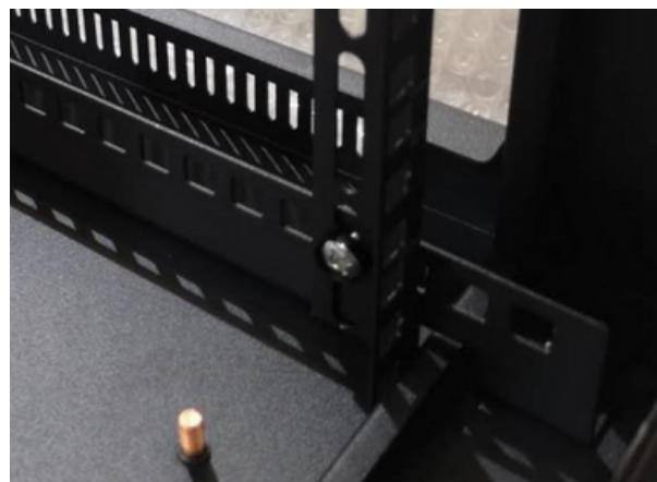
Fixez les profilés à leurs extrémités aux supports de montage. Positionnez les vis M6 et leurs écrous dans le 4<sup>e</sup> trou des supports de montage à partir de l'extérieur et dans le 1er trou des profilés.
